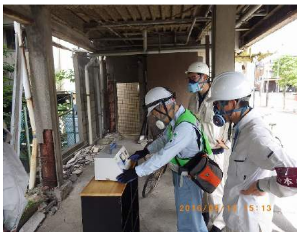
ファイバーモニター を設置して繊維の 飛散状況の調査
