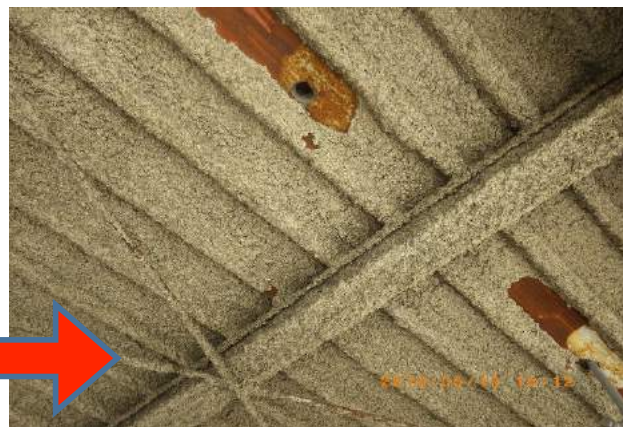
駐車場天井・梁の 吹付ロックウール
