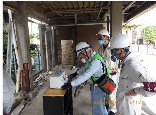
吹付の有る建物での気中濃度測定
