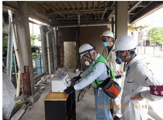
吹付の有る建物での気中濃度測定
