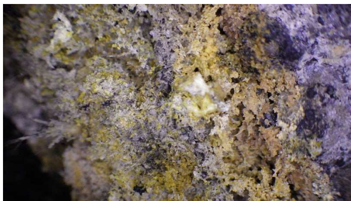
煙突断熱材の落下物 アモサイト
